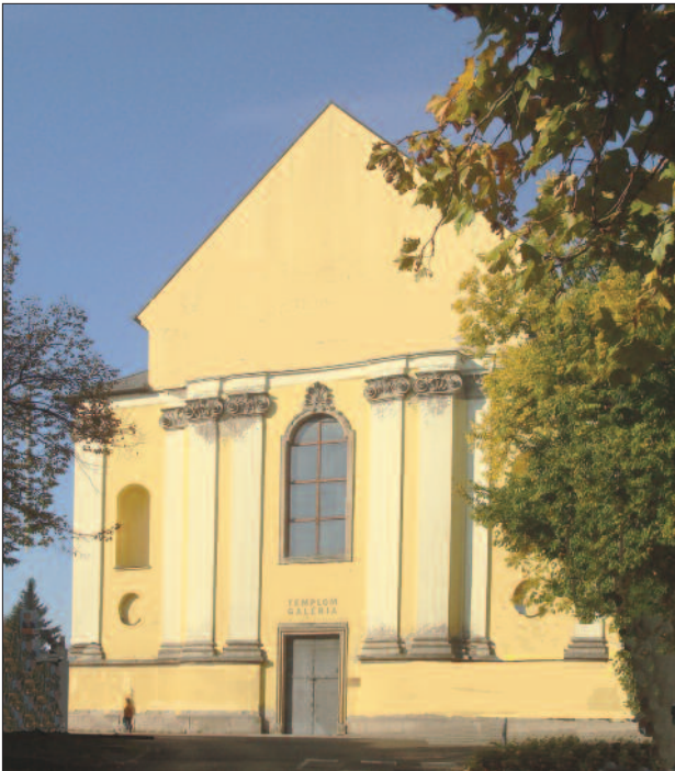
4. ábra. A trinitárius templom homlokzata
