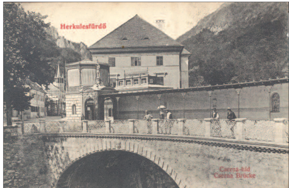
4. ábra „Herkulesfürdő / Cserna-híd”
